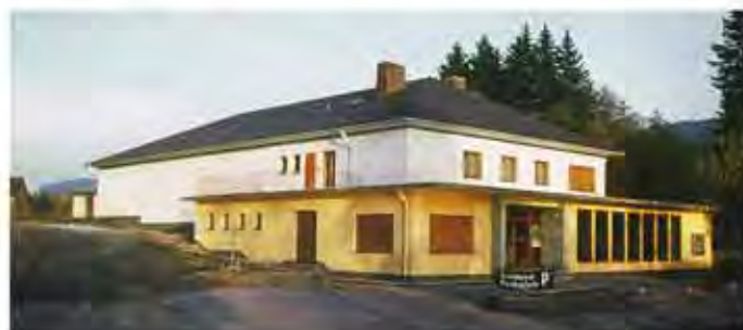
Letzte Erdarbeiten; Das Kino kurz vor der Eröffnung 1962
